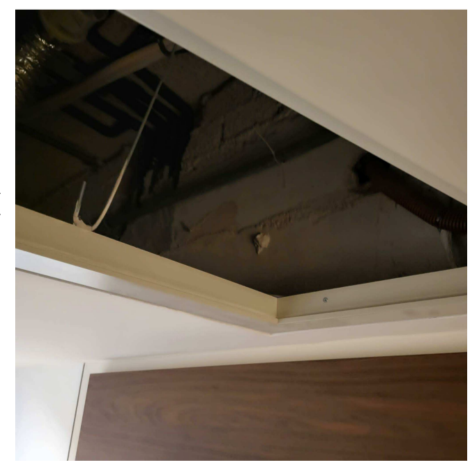
DETALLE FALSO TECHO REGISTRABLE
